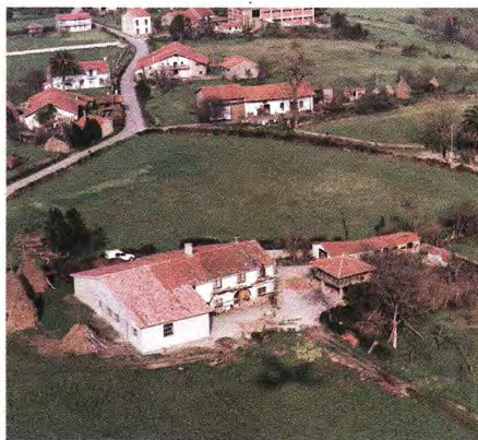
Edificación agrícola en Villaviciosa (Zona de La Marina)
