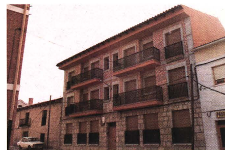
Edificio nuevo mal integrado. Villanubla
