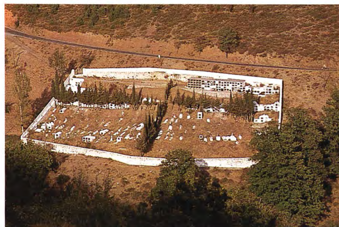
...sistema de equipamiento...
